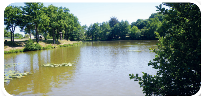
➤ Avant travaux : un plan d'eau sur cours d'eau
