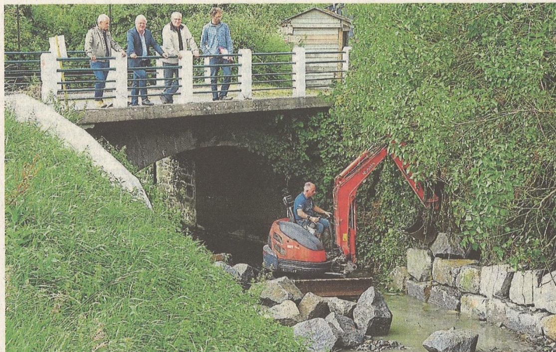
Premier d'une longue série de travaux dans le fleuve Guyoult, la réfection de la berge a nécessité la présence d'une mini-pelle à même le lit de la rivière.
