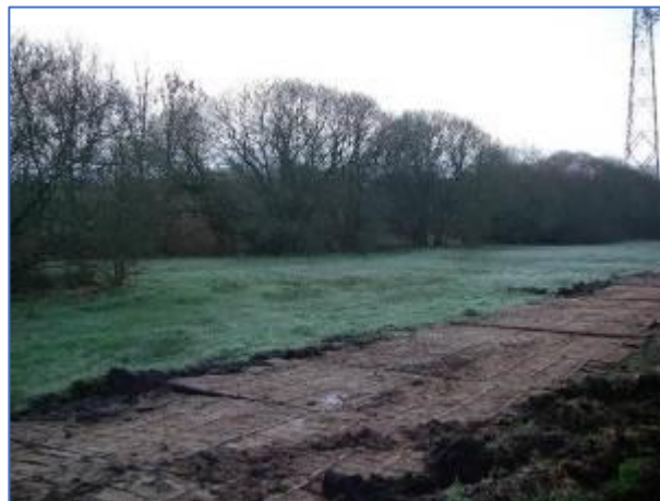
Figure 36 : Exemple d'un cheminement provisoire en bois qui protège le sol de la parcelle (bassin du Rion, chantier ERDF)
