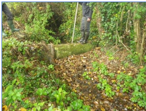
Présence d'une prise d'eau composée d'un seuil en travers et d'une buse
