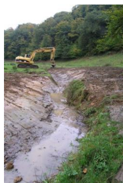
Restauration du gabarit originel du cours d'eau
