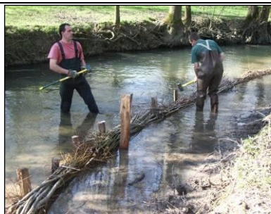
Réalisation de fascine en pied de la nouvelle berge
